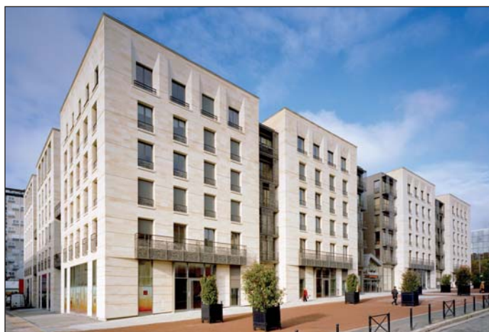
ILOT BONNAC • Architecte : Cabinet BUFFI ASSOCIES • Maître d'ouvrage : EIFFAGE
